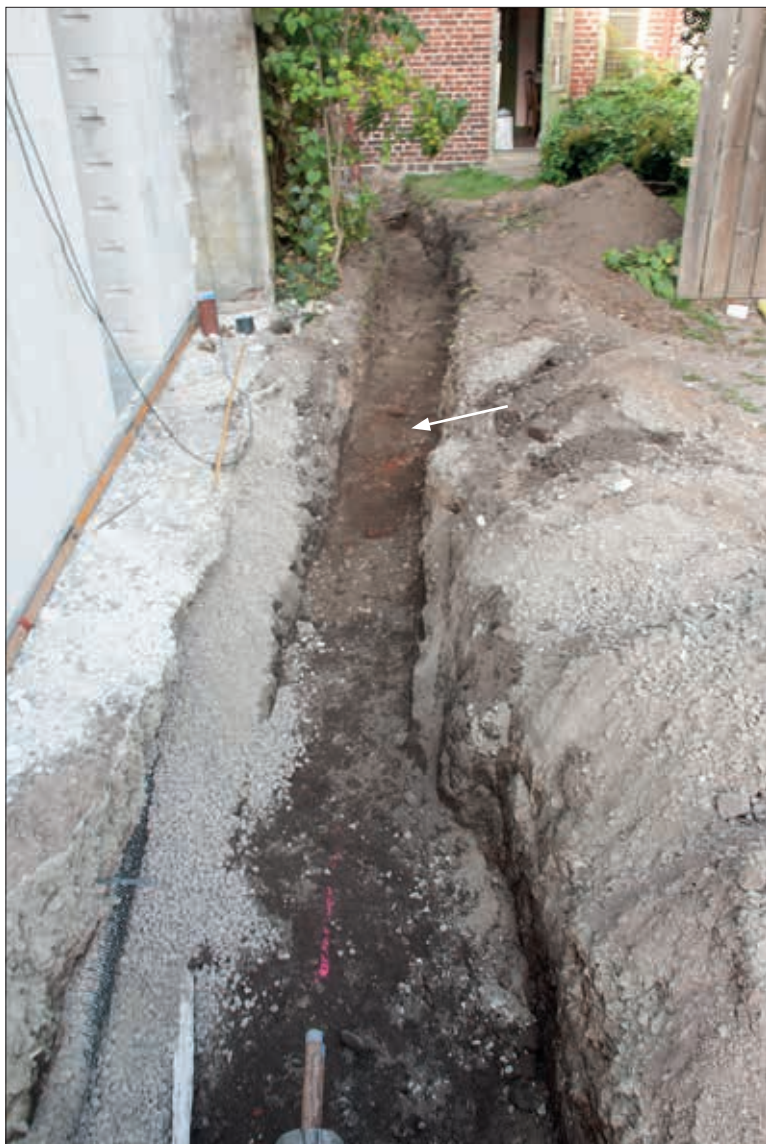
Fig 8. Fjärrvärmeschaktet där raseringslagret för klostermuren påträffades. Pilen markerar platsen. Mot NNO. Fotograf: Lena Bjuggner (fotonr: 2016-36-6).
