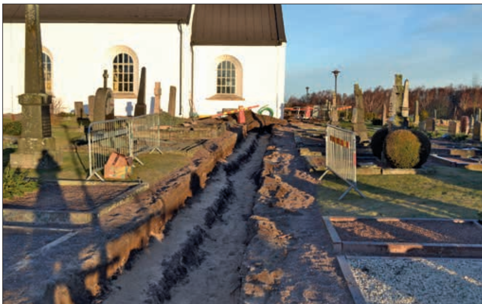
Figur 6. Översikt schaktet som löper från kyrkans östra del vidare söderut över kyrkogården. Sand att placera rören i har lagts ned i schaktet. Mot N. (Fotonr 2016-74-5). Foto: Stina Tegnhed.
