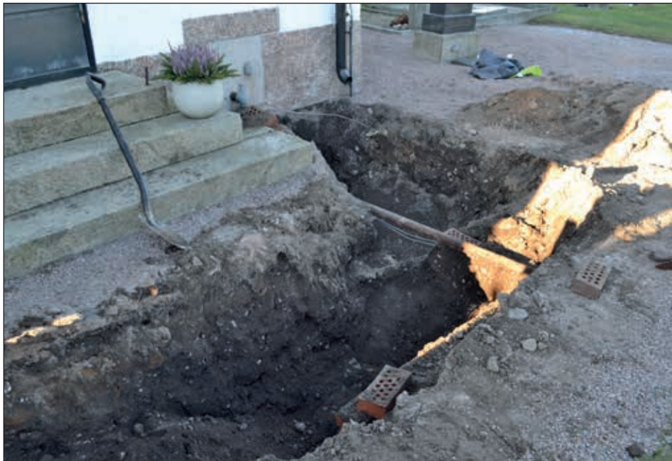
Figur 5. Schaktet öster om kyrkan. Anslutningen till kyrkans östvägg är framschaktad. Mot NV (Fotonr 2016-74-2). Foto: Stina Tegnhed.
