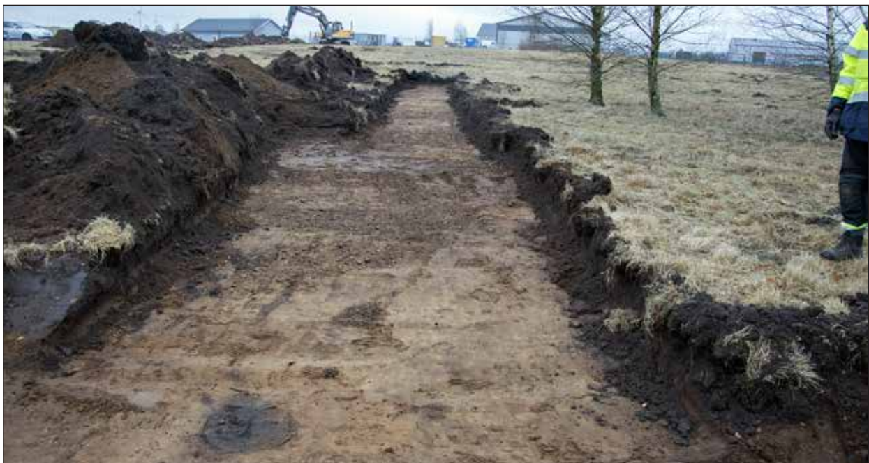
Fig 6. Schakt OS450, efter utökning för att söka angränsande anläggningar till stolphålet på bilden, som var det enda påträffade stolphålet i utredningen, mot söder. Foto: Mats Nilsson. (Fotonr. 2017-12-8).
