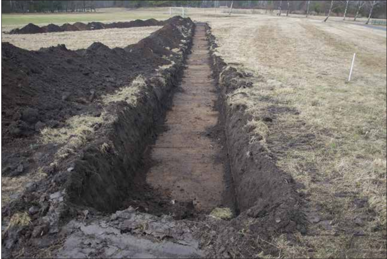
Fig 5. Schakt OS363, med matjordsfyllning upp till 1,3 meter öster om fotbollsplan, mot väst. Foto: Mats Nilsson. (Fotonr. 2017-12-7).
