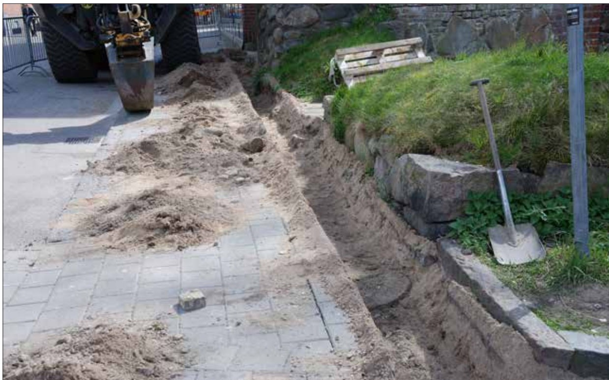
Fig 5. Schaktet med grundstenar och västlig sten vid södra kasematten på Våghalsbastionen (under svensk tid Västra bastionen). Mot SO. Foto: Lena Bjuggner (fotonr 2017-41-3).
