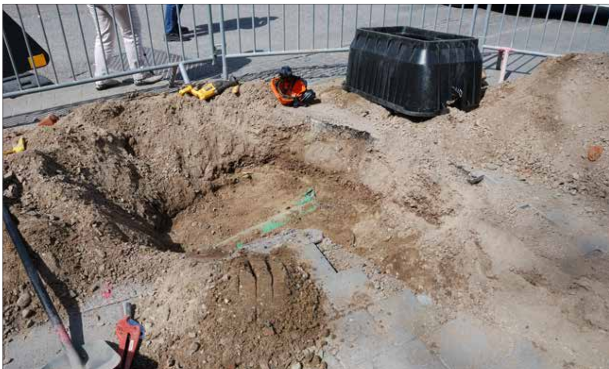
Fig 6. Utvidgad grop i väster med kablar i botten och plats för kabelbrunn. Mot NV. Foto: Lena Bjuggner (fotonr 2017-41-5).
