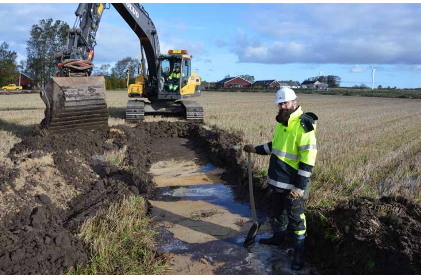
Figur 4: Vattnet trängde på många delar av området upp direkt ur marken så fort vi banat av matjorden. Detta ger att ytvattnet var mycket högt vid utredningstillfället, hur grundvattnet ligger i området vet vi inte. Foto: Mats Nilsson, Kulturmiljö Halland. (fotonr. 2017-93-02).
