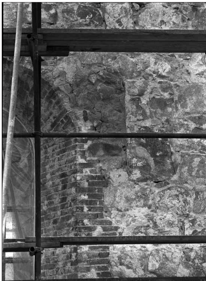
Fig 5. Igensatt romanskt fönster på norra fasaden. Foto: Anders Tilly (fotonr 88:13:10).
