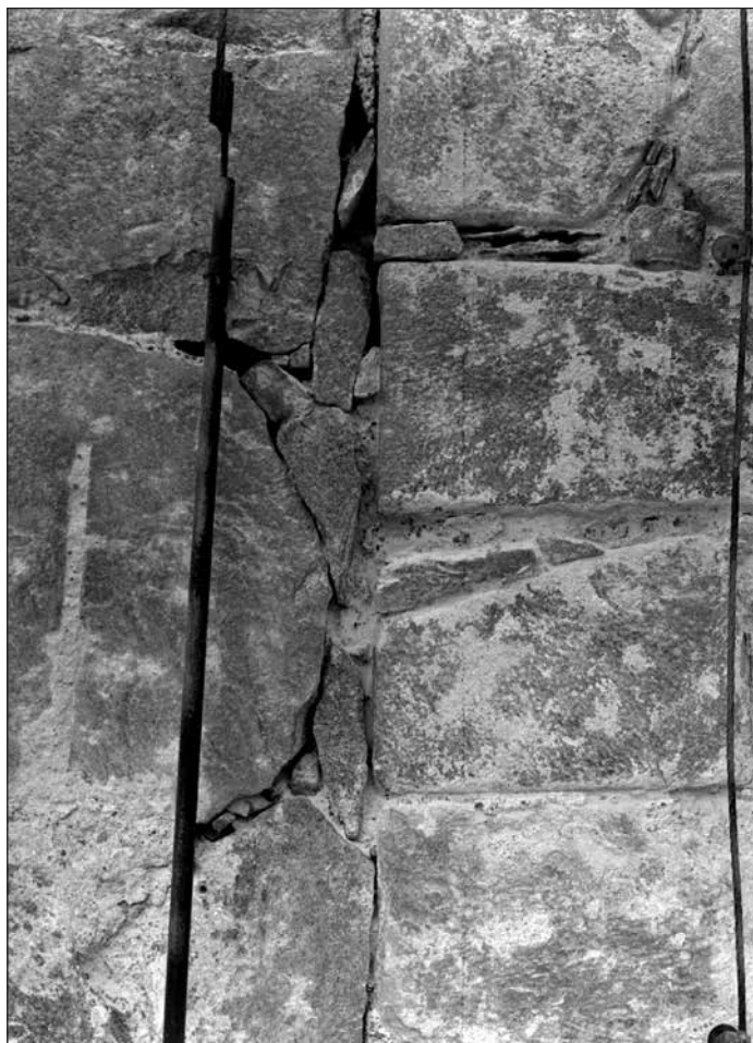
Fig 2. Detalj av stötfog mellan långhus och torn, södra sidan. Foto: Anders Tilly (fotonr 88:16:2).
