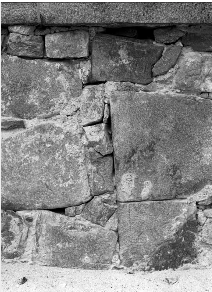
Fig 3. Detalj av stötfog mellan äldre långhus och förlängd del av långhus, södra fasaden. Fot: Anders Tilly (fotonr 88:16:3).
