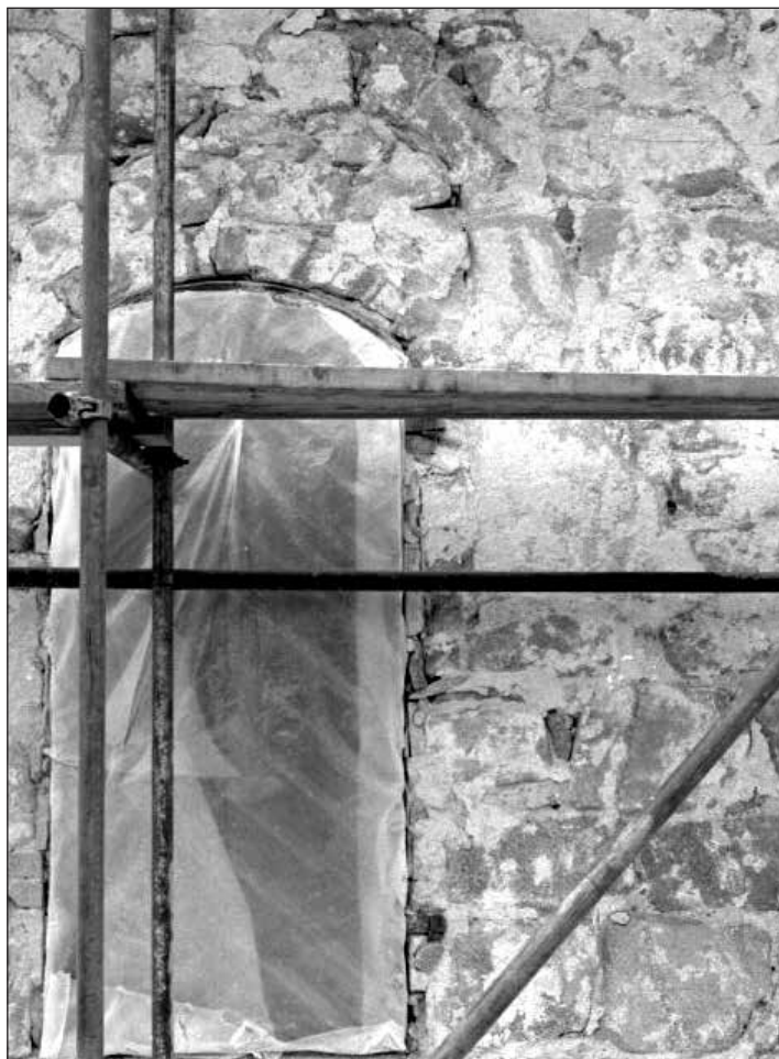
Fig 6. Detalj av igensatt romanskt fönster norr om dörr i koret. Mot V. Foto: Anders Tilly (fotonr 88:15:2).
