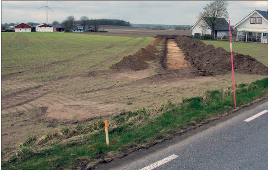
Fig 3. Södra delen av schakt 200 mot norr, från Tjärbyvägen. Foto Mats Nilsson. (fotonr. 2018-22-1).
