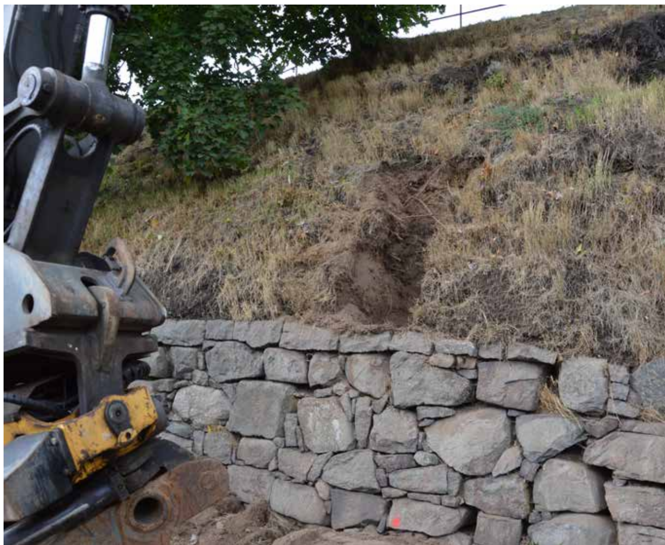
Figur 2. Pågående grävning av provgrop BT12.
