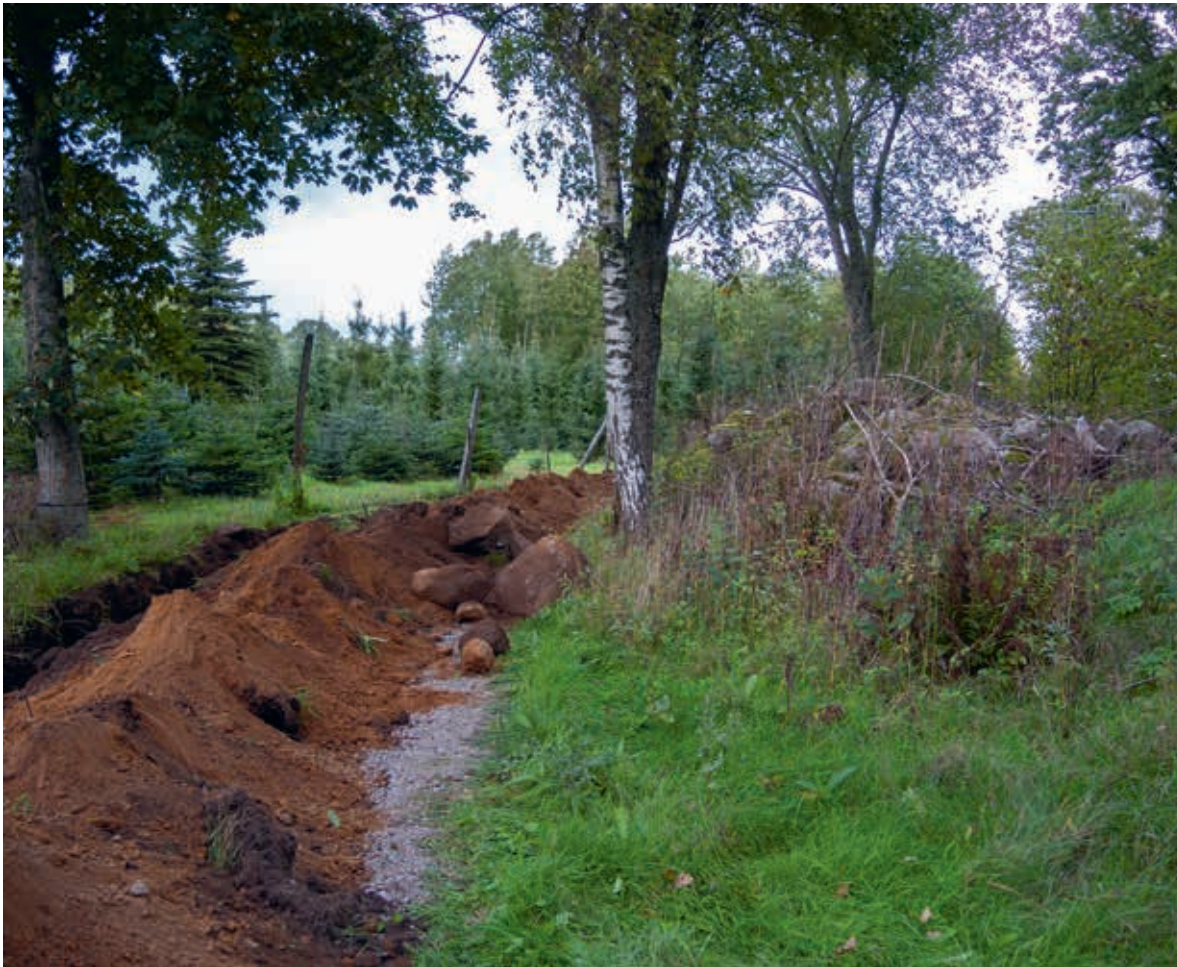
Figur 3. Ledningsschakt mot öst med gravröse RAÄ 13:5 till höger i bild. Foto: Mats Nilsson (fotonr. 2018-67-1).
