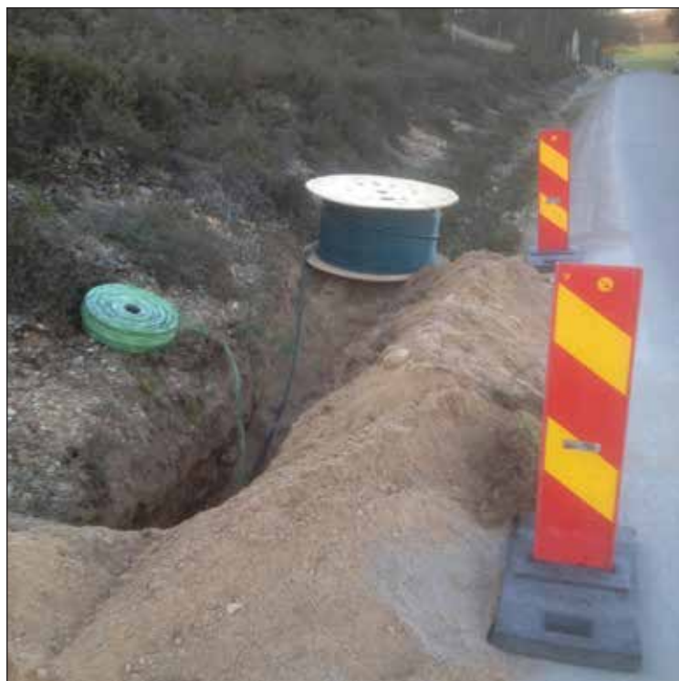
Fig 2. Fiberledningsschakt längs Livägens östra del. Fastighet LI 2:23. Mot söder. (Fotonr. 2019-22-8). Foto Mats Nilsson.
