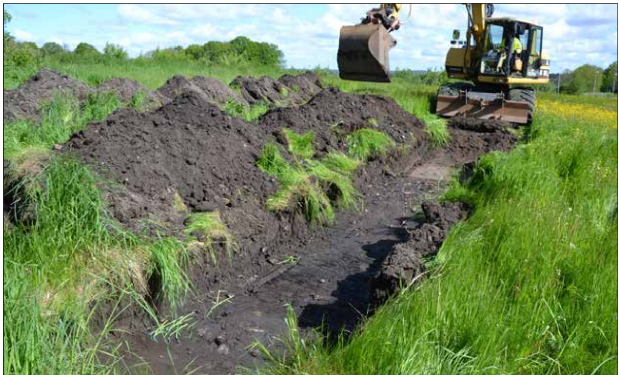
Figur 5. Schakt 220 mot NO. Foto: Stina Tegnhed. (Fotonr: 2019-44-1).
