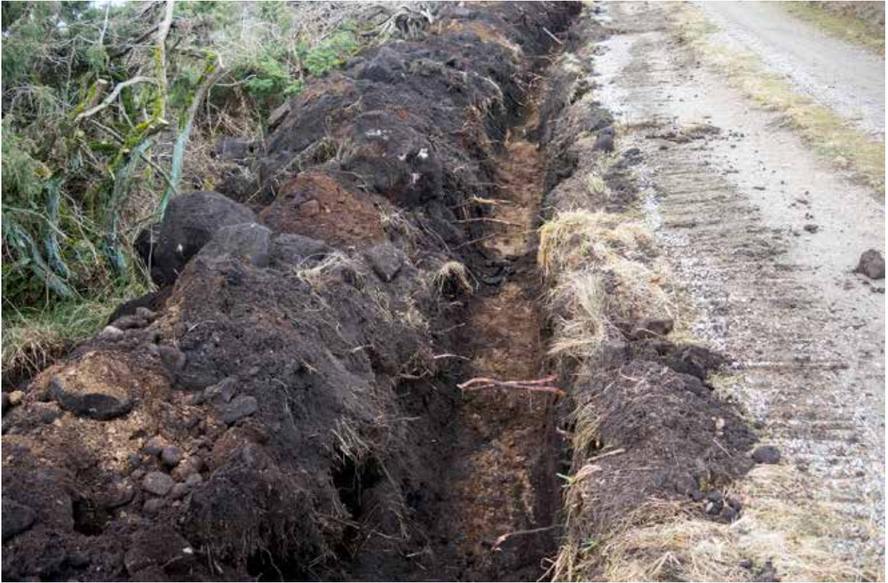
Figur 4. Schakt OS515. Schaktet och direkt omgivning. Delyta A. Mot väst. Foto: Jonas Carlsson. (Fotonummer 2021-07-01).
