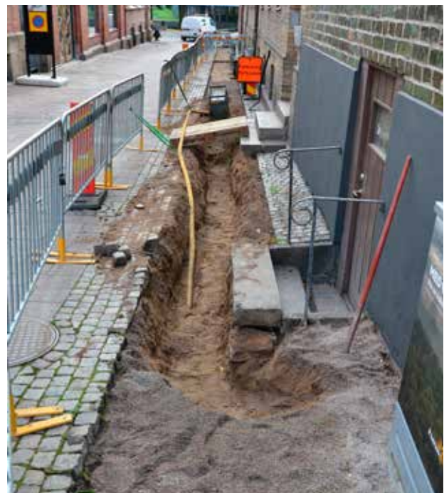
Figur 4. Schaktets utbredning i Bastionsgatan, fotat mot öster från schaktets startpunkt i nordväst. Fototr: 2022-31:1 Foto: Sofie Renström.
