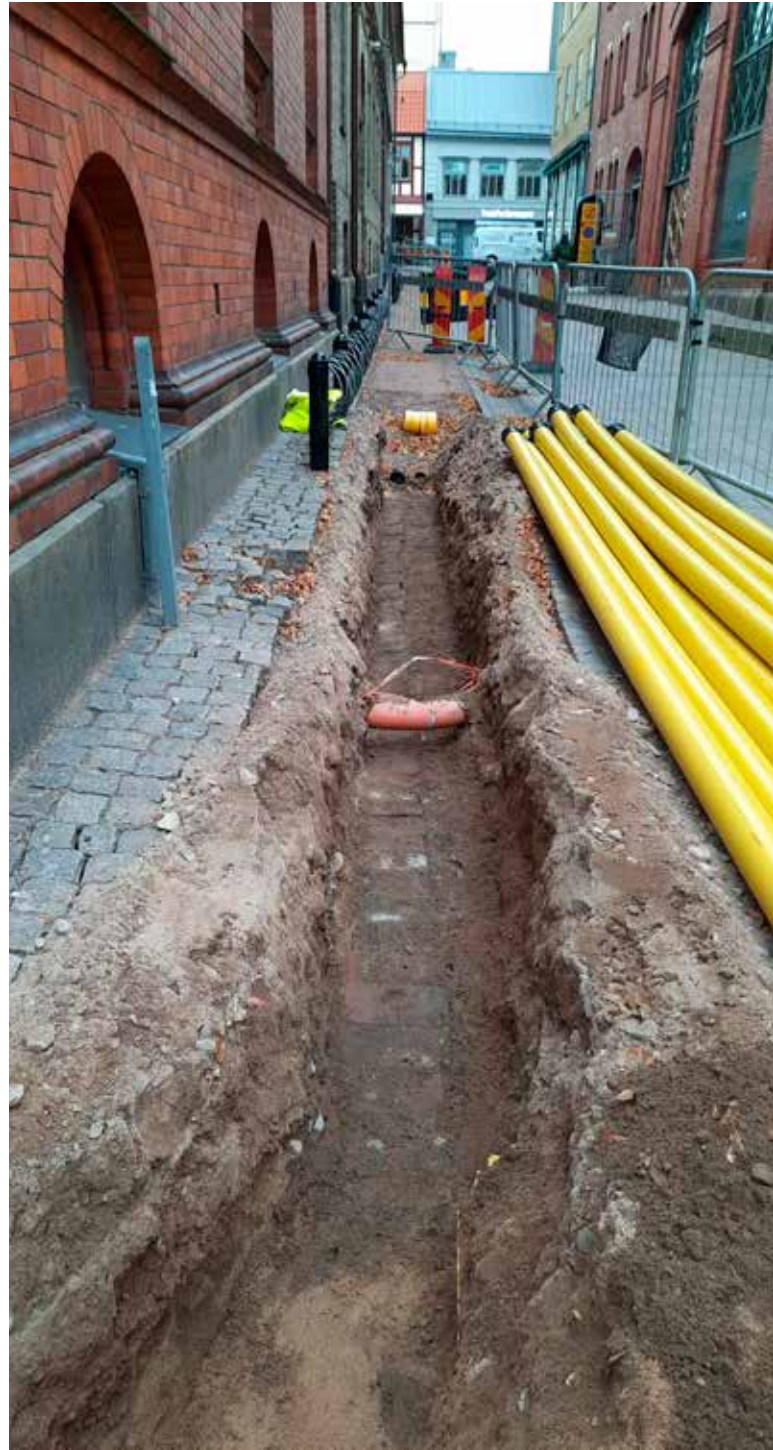
Figur 6. Tegelstenar lagda som skydd över äldre ledning är synliga i schaktbotten i den östligaste sträckan i Bastionsgatan. Fotonr: 2022-31:8 Foto: Johan Klange
