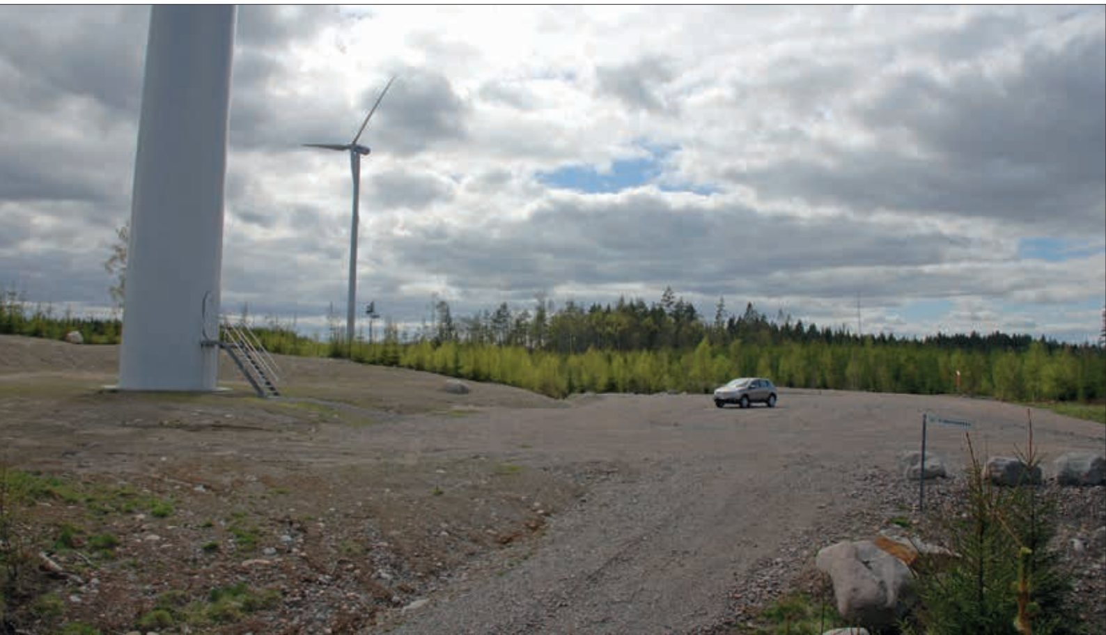
Fig. 3. När man besöker uppställningsplatserna i verkligheten blir det tydligt hur viktigt det är att en stor yta inventeras. Det är långt ifrån alla verk som har en uppställningsplats som håller sig inom 50 m radie utifrån den koordinat som anges för verket i underlagen. Det händer också att verksplatser och vägdragningar justeras, vilket även det är ett argument för att så mycket som möjligt skall vara inventerat så att inga försenande kompletteringar behöver genomföras.
