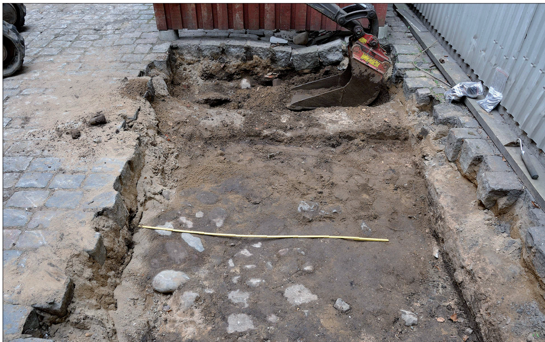
Fig 8. Igenläggning av schaktet. Foto mot öster. Foto: Fredrik Larsson. (Fotonr. 2014-67-25).
